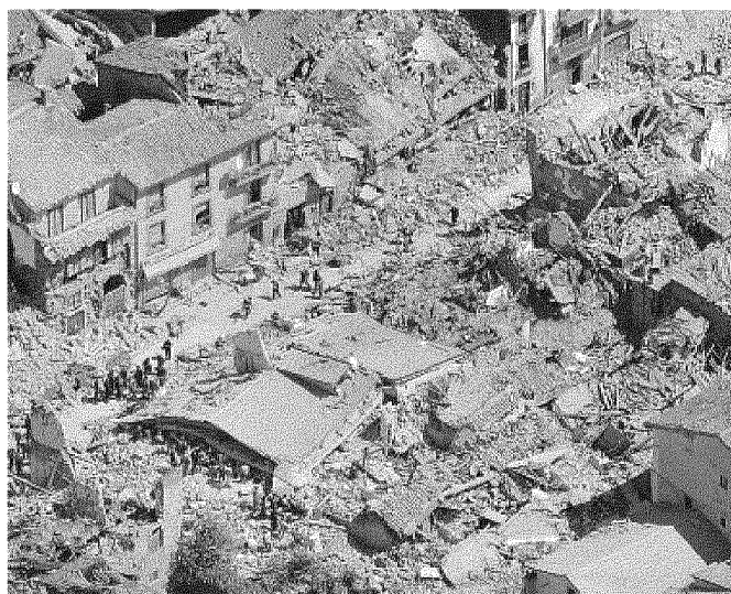
Amatrice. Una veduta dall'alto della cittadina colpita dal terremoto. FOTO: ANSA
